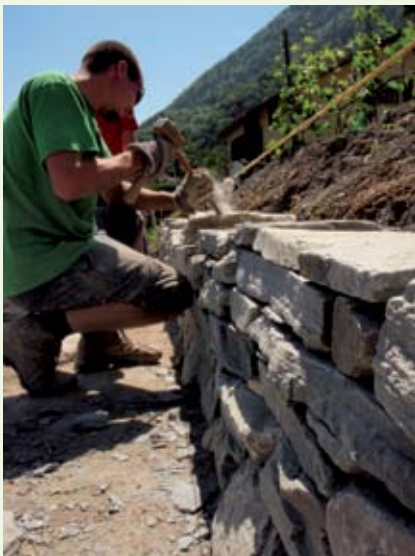
Façonnage de pierres pour la couverture
